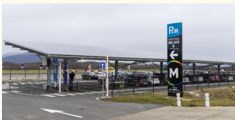
Parking relais avec Ombrières (source : grenoblealpesmetropole.fr )
