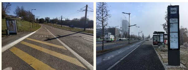
Exemple de site propre bus à Besançon et au Luxembourg (source : Explain)
